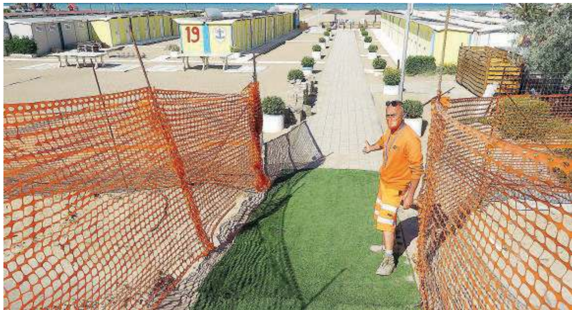
I lavori per i nuovi accessi in spiaggia a Marina centro con verde e passerelle in legno
