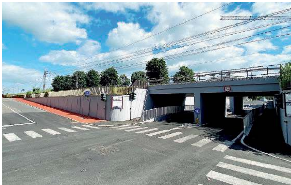
I lavori completati del sottopasso per accedere verso la zona del mercato e dell'area di Misano Brasile
