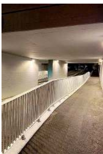
La parte pedonale del sottopasso
